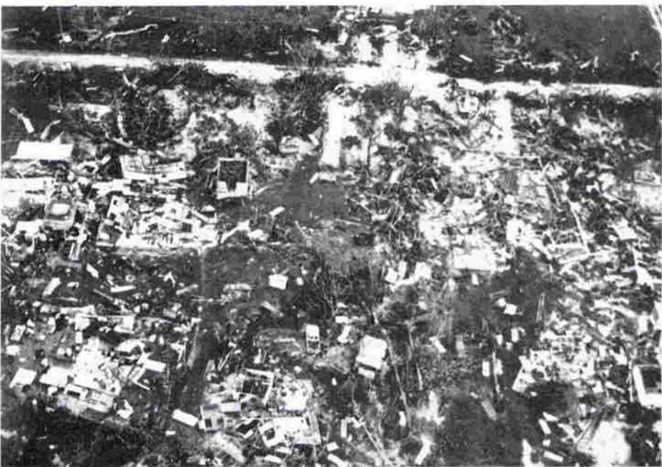
Les logements non conçus pour résister aux vents violents ont été détruits (Atoll d'Arutua).
