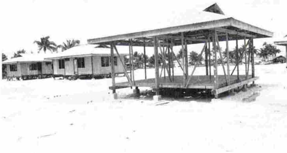
Une construction de l'ATR mieux adaptée au risque.
