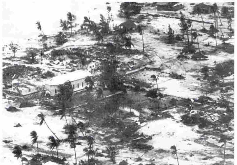
Accumulations de sable et de débris coralliens dans le village de Tuuhora, côté lagon
