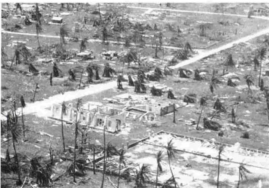
Cocotiers, bâtiments et citernes endommagés (Atoll d'Arutua).
